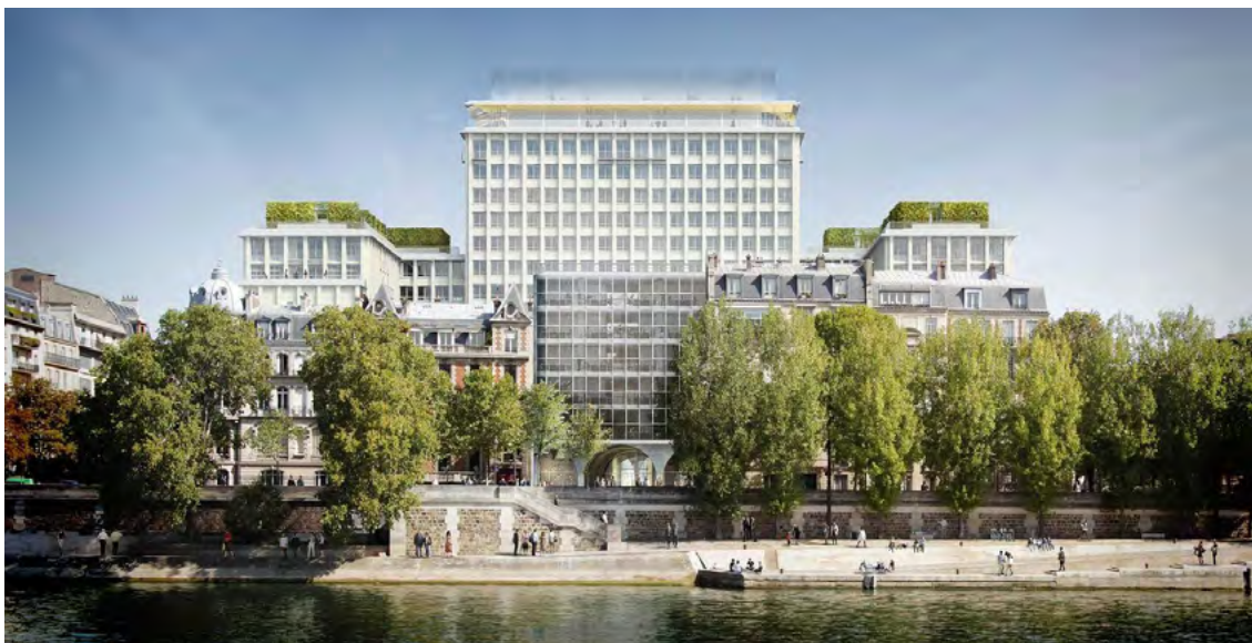
Vue du siège LBP AM/TFSA - Paris ©David Chipperfield Architects
